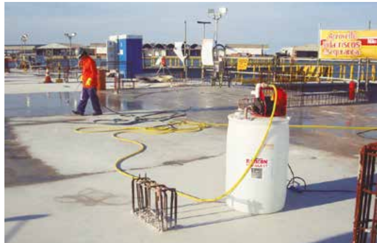
El Radcon Fórmula #7 crea una protección de hasta 2 cm de profundidad.
