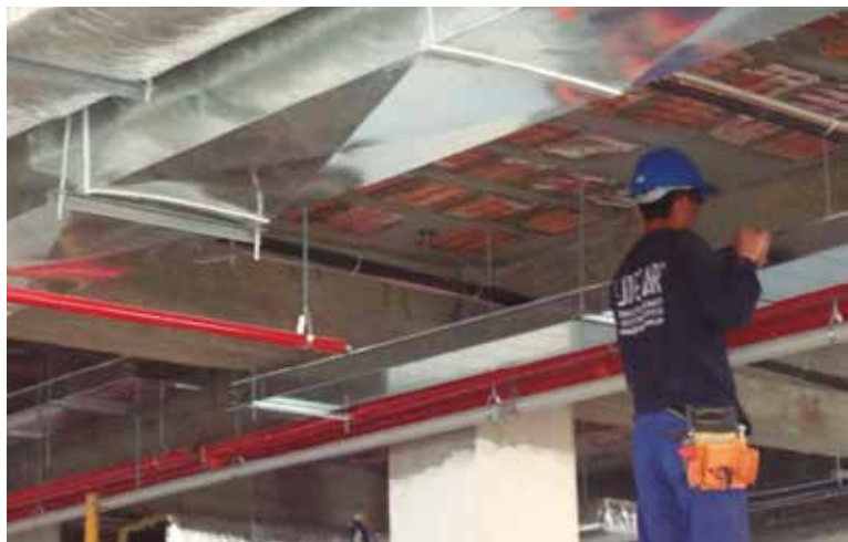
Sujetar colocó 2,500 piezas de 6 metros de largo en la Refinería de Talara.
