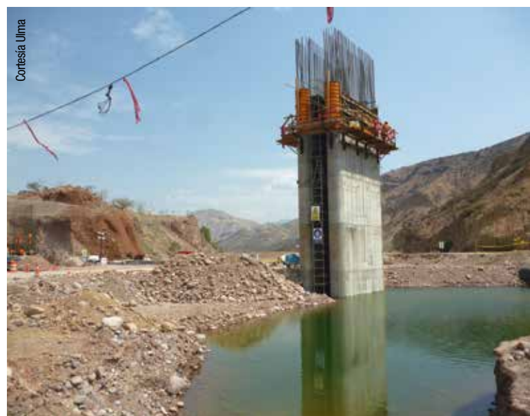
Vista de la construcción del pilar del puente. Una vez terminado se procedió con la ejecución de la dovela cero.
