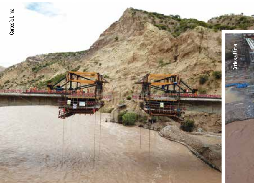
Con el sistema carro de avance se inicia la ejecución del tablero del puente, en tramos de 4 ó 5 metros.
