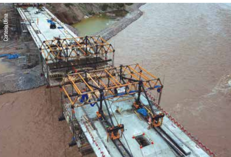
Con el sistema carro de avance se inicia la ejecución del tablero del puente, en tramos de 4 ó 5 metros.
