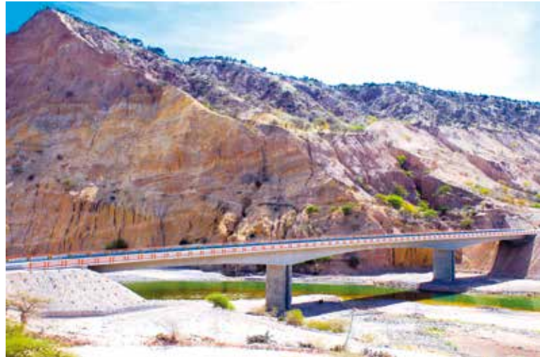
Los pilares tienen una altura de 16.70 m y en su cimentación se hincaron 12 pilotes por pilar.
