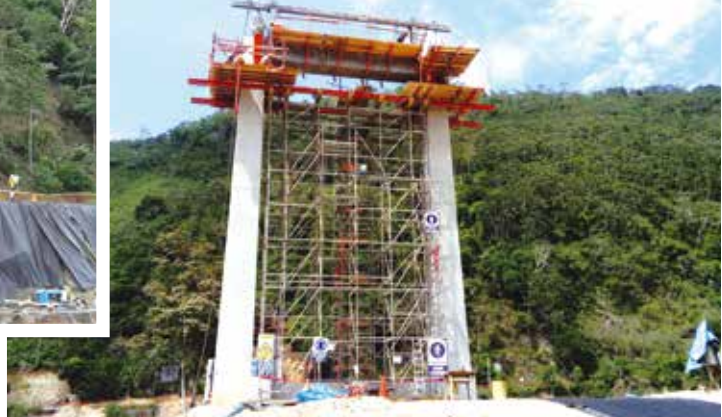
El puente cuenta con dos mástiles dobles que elevan los cables hasta 17 m de altura.
