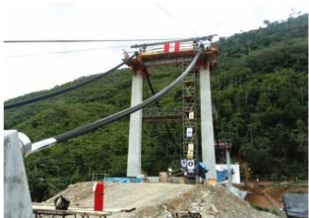
Los cables principales del puente se anclan en ambos extremos en macizos de concreto dentro de los cuales se dispone una cámara de tensado.
