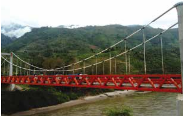
El tablero metálico está compuesto por dos celosías, unidas por traviesas metálicas dispuestas cada 2,50 metros.
