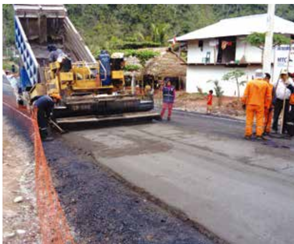
El puente forma parte de la Carretera Longitudinal de la Selva Sur, y su ejecución incluyó la construcción de los accesos adyacentes a la megaestructura.
