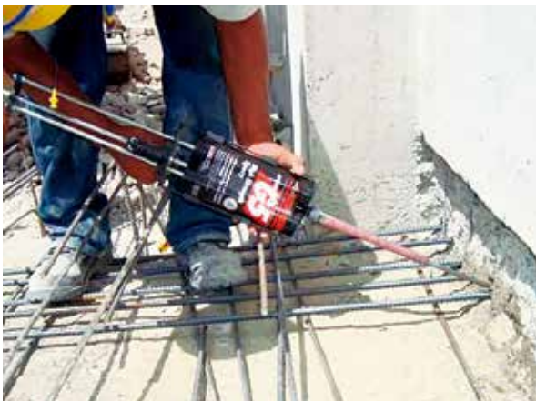
Las resinas epóxicas estructurales están diseñadas para soportar cargas amplias y dinámicas en el tiempo, sobre todo en proyectos de ampliación o reforzamiento.
