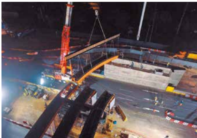
Para la construcción de los nuevos viaductos se utilizaron vigas pretensadas y prefabricadas de concreto, así como vigas metálicas, dependiendo del diseño.
