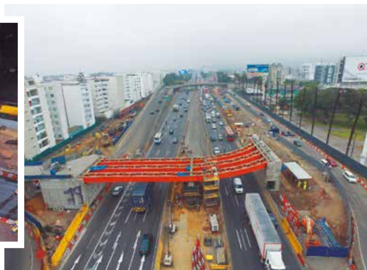
Para la construcción de los nuevos viaductos se utilizaron vigas pretensadas y prefabricadas de concreto, así como vigas metálicas, dependiendo del diseño.
