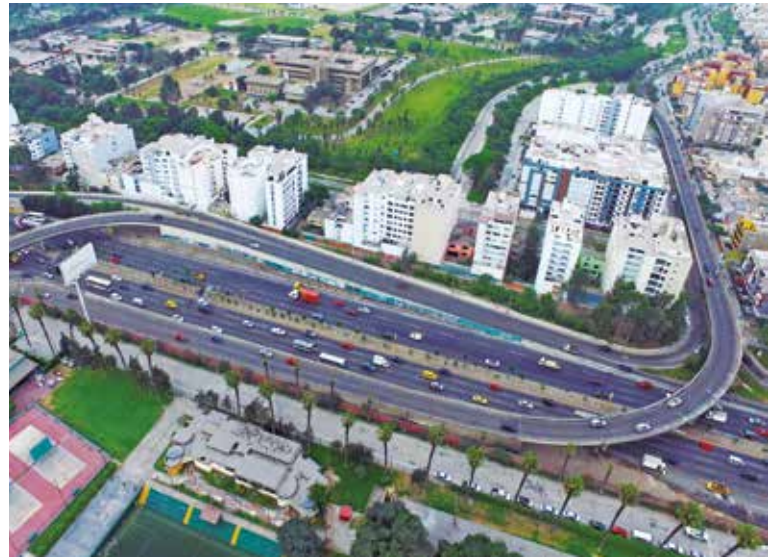
Vista del Intercambio Vial El Derby antes su intervención.
