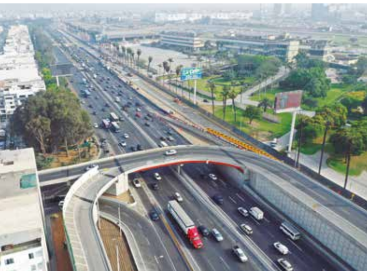
Vista de los tres carriles del ramal 1, de los cuales dos desembocan la avenida San Borja Norte y el tercero facilita la conexión con la Panamericana Sur sentido sur (Ramal 5).
